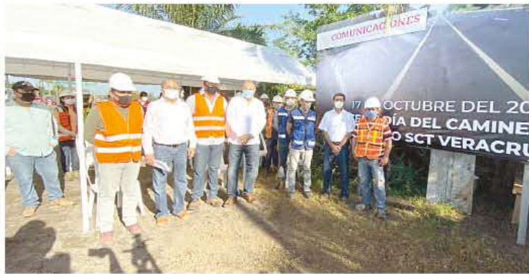
RAMÓN ÁLVAREZ asistió al recorrido de la obra de ampliación de la carretera Veracruz-Xalapa.
