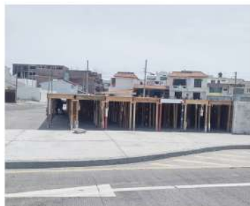
ENEL SALSÓDROMO ubicado en el bulevar Vicente Fox, ya trabajan colocando algunas estructuras para el escenario principal y gradas.
