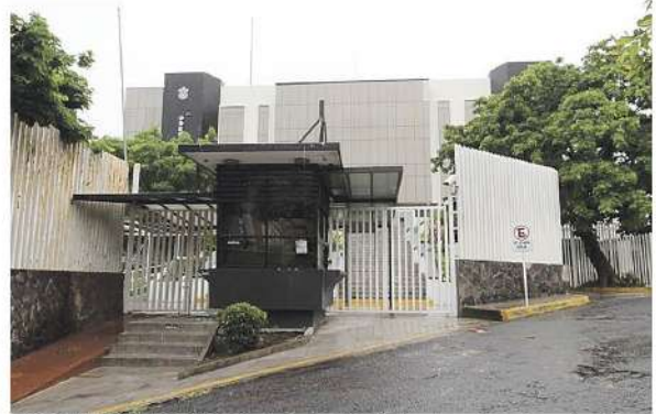
LAS INSTALACIONES UBICADAS en la colonia Ortiz Rubio siguen presentando algunos desperfectos.
