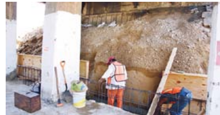
SE HARÁN DIVERSAS OBRAS de refuerzo en la estructura.
