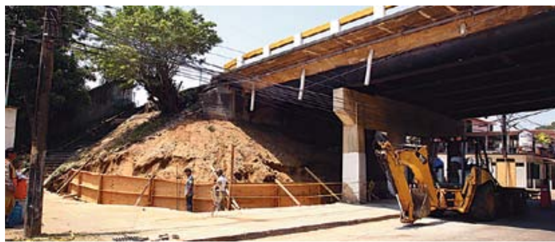
LOS TRABAJOS DE REPARACIÓN en el Tabud del Puente Palma Sola ya comenzaron.
