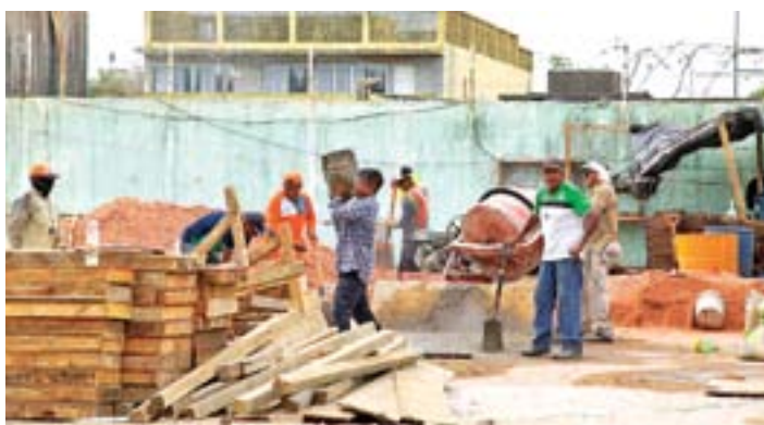
LOS ALBAÑILES son de las personas que por su labor tienen que pasar largas jornadas bajo el Sol.
